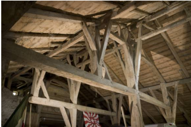
Firstständer-Dachkonstruktion. Bäuerlicher Vielzweckbau von 1621/24 in Renan, Envers des Convers 87. Foto: Jacques Bélat
